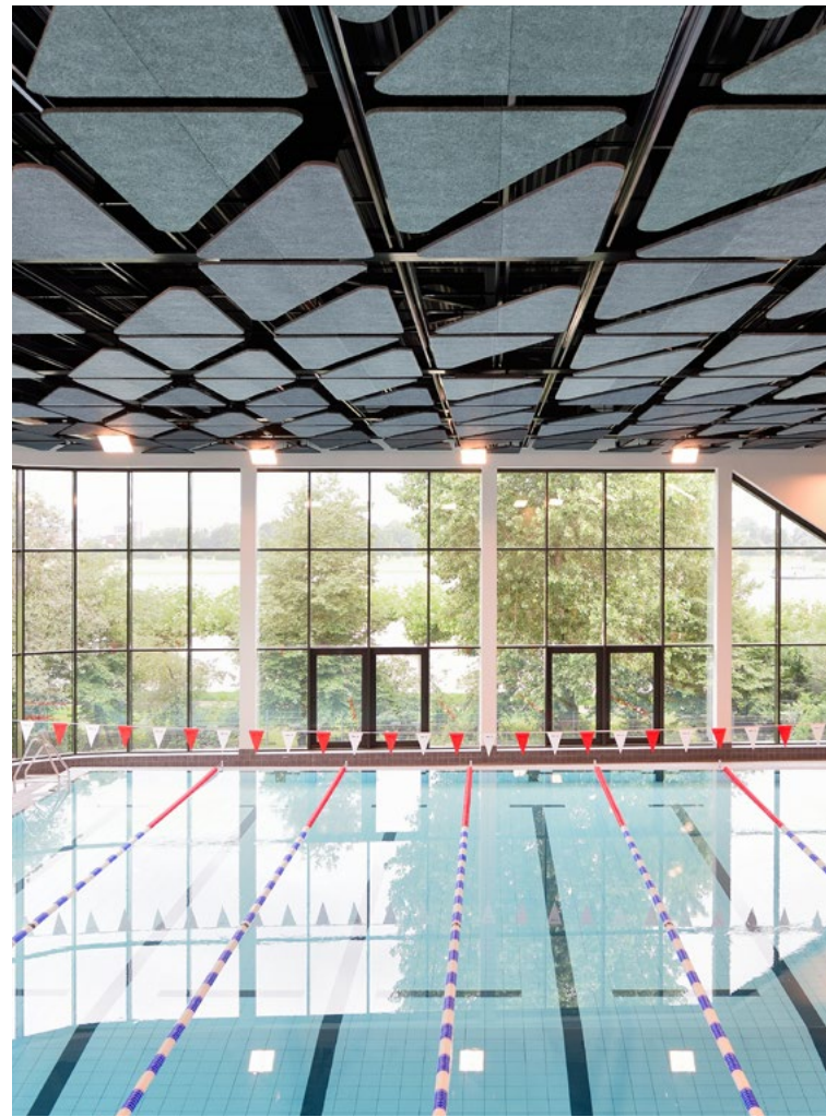
Schwimmbad „Rheinblick 741 - Begegnung am Wasser“, Oberkassel
