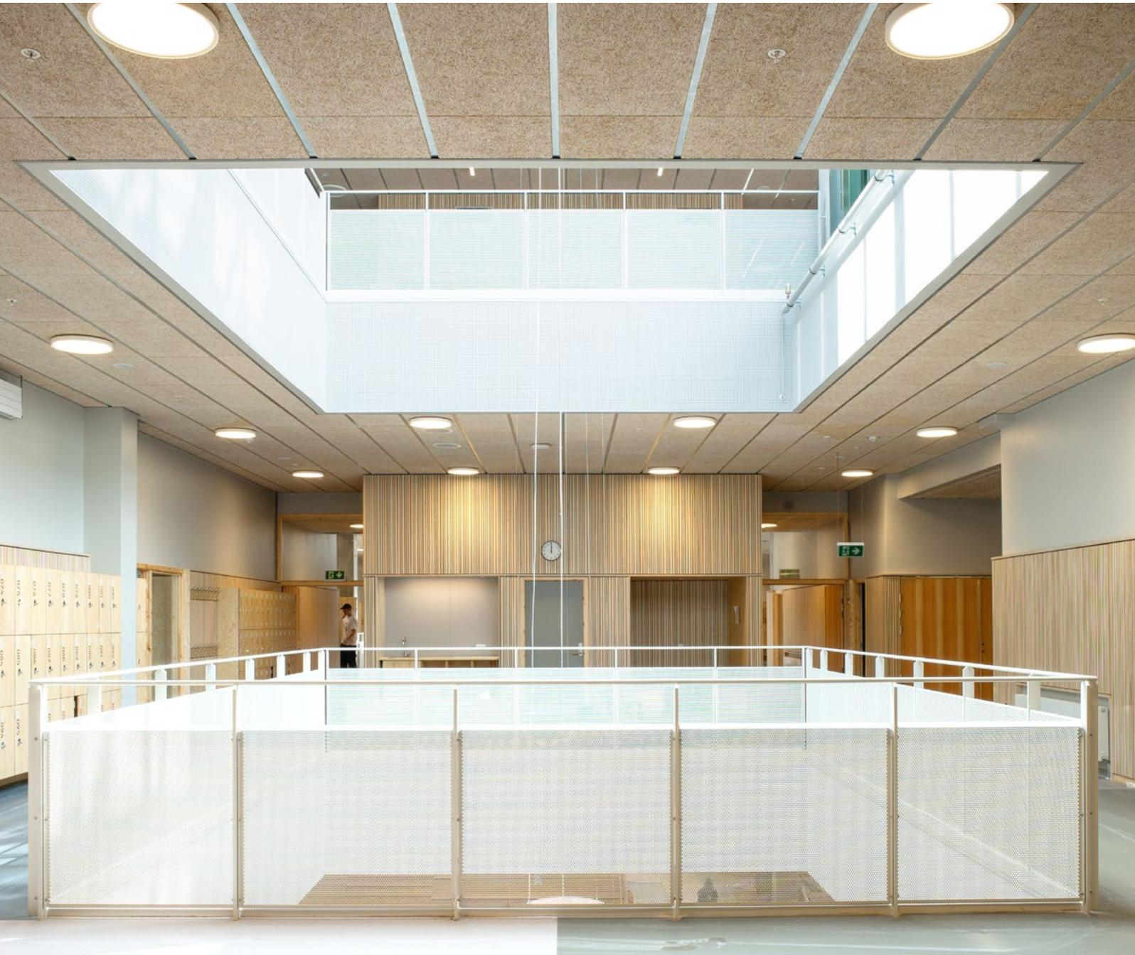
Die Lösung mit sichtbaren längslaufenden T-Schienen hat Trolldtek in Zusammenarbeit mit JJW Arkitekter für das Projekt der Schule Sluseholmen in Kopenhagen entwickelt. Deshalb nennen wir die Lösung auch „SLUS-Decke“.
